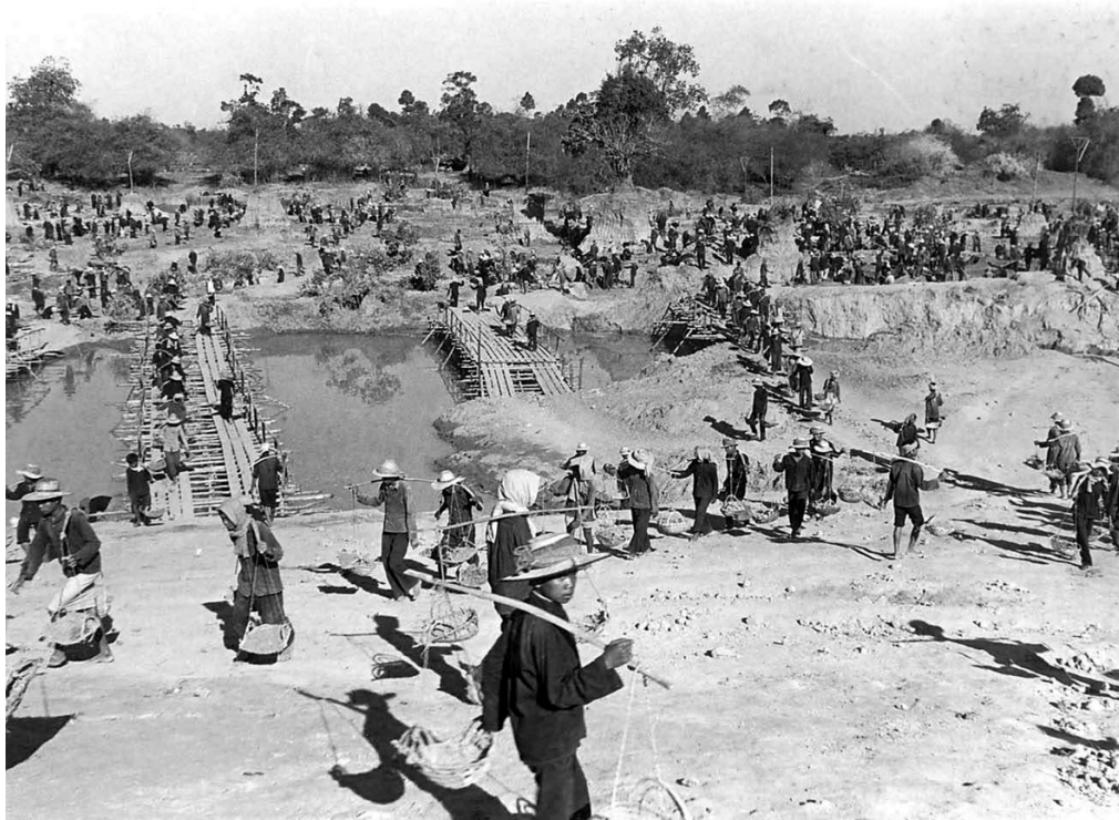
Chantier hydraulique 1975-1979. Centre de documentation du Cambodge, Phnom-Penh.
